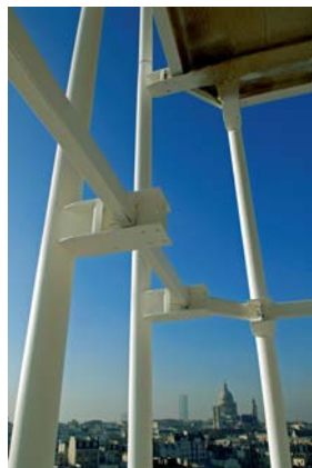
Tour Jussieu, rénovation T. Van de Wynaert © DR
