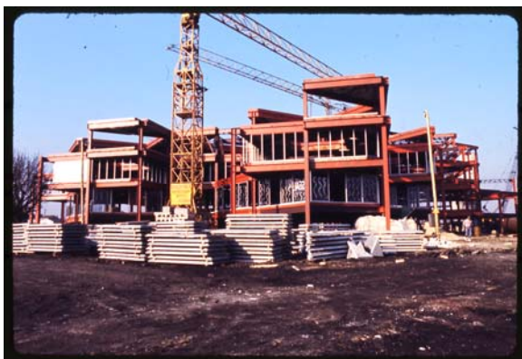
Chantier école d'architecture Nanterre, 1971 © DR
