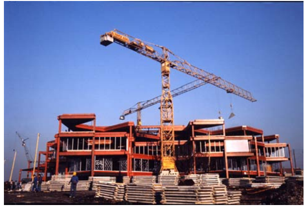
Chantier école d'architecture Nanterre, 1971 © DR
